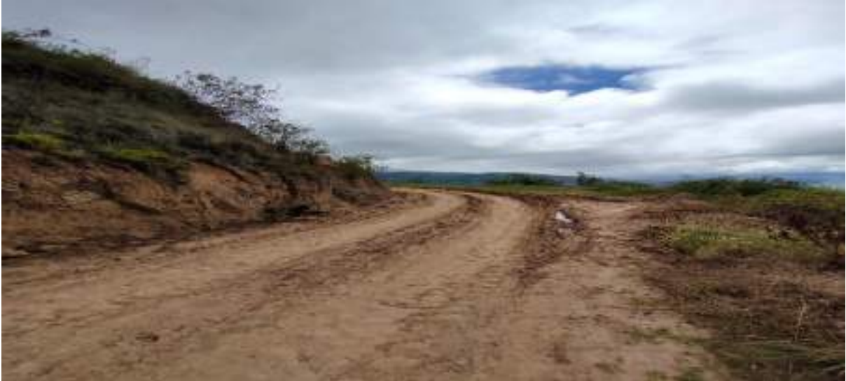
Imagen 10. Obstrucción de la vía por deslizamientos de tierra en temporada de invierno Fuente: Elaboración Propia
