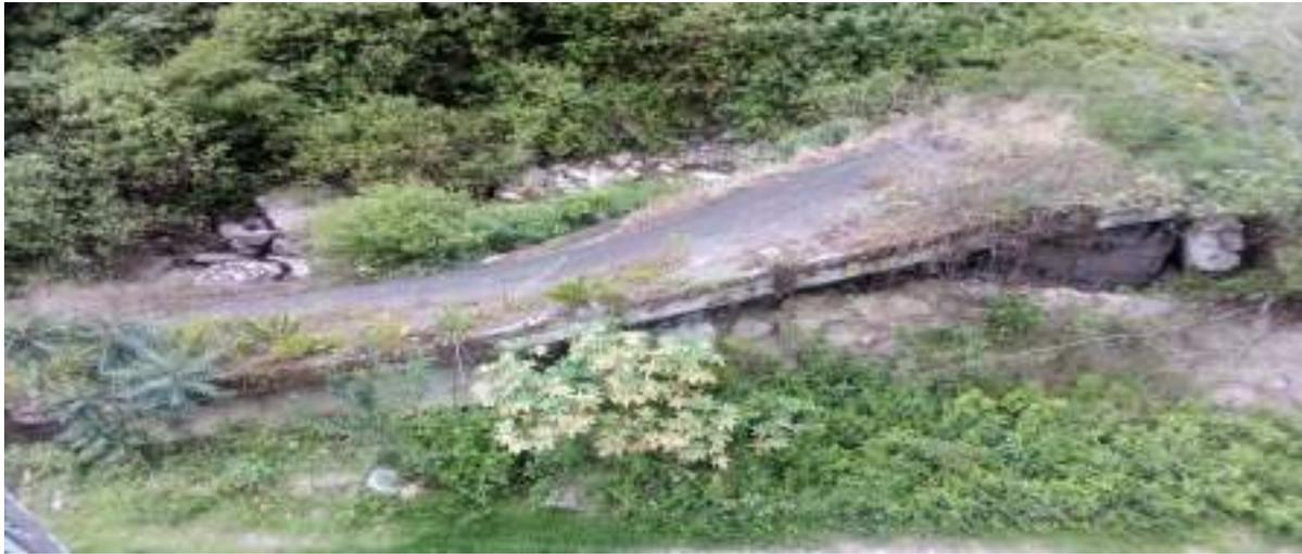
**Imagen 8. Puente destruido por el aumento del caudal del río.**
