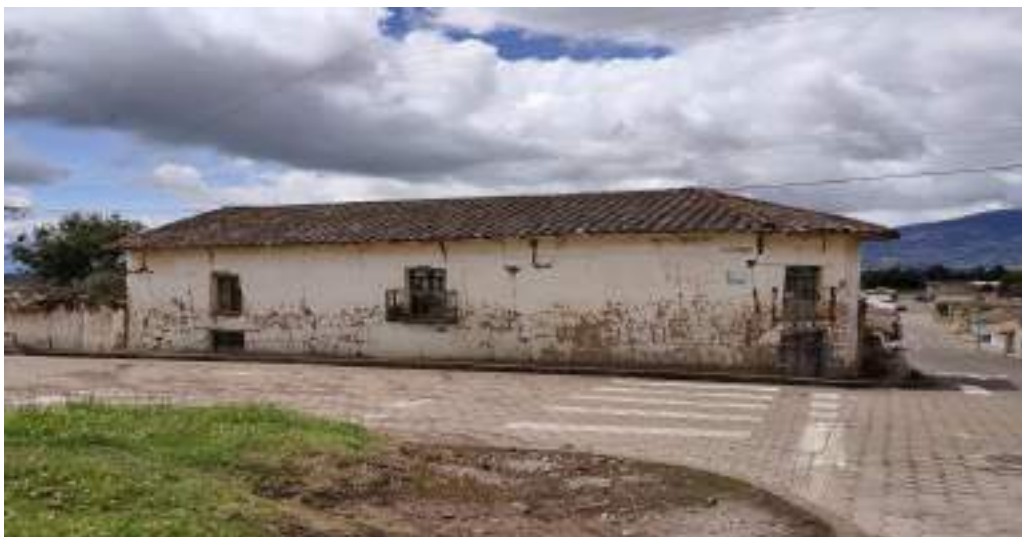
Imagen 11. Vivienda en mal estado.
