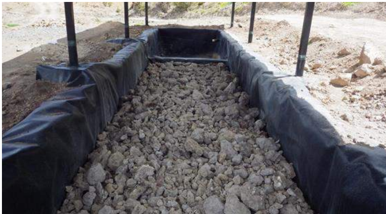
Fotografía 7-2 Piscina para Tratamiento de Lixiviados
