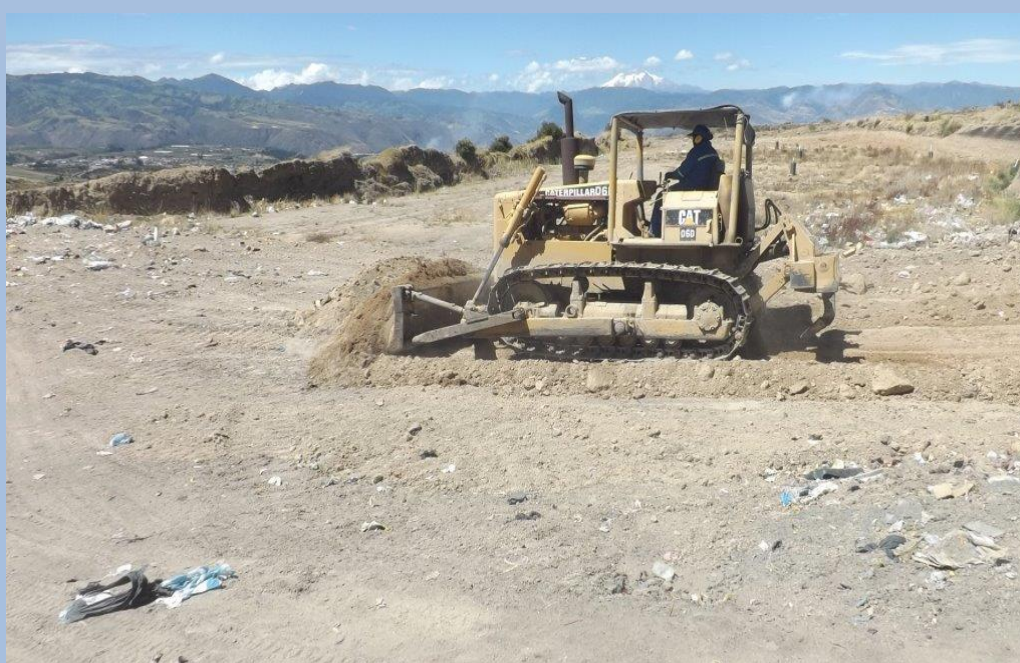
Trabajos de compactación y cobertura de los residuos sólidos Fecha: 18 de Octubre del 2016 (Segunda Plataforma)
